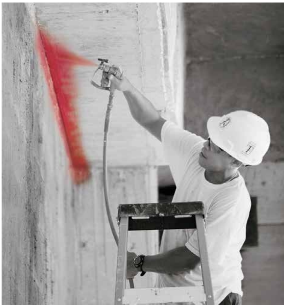
Figura 23 – Marcação de Compartimentação
