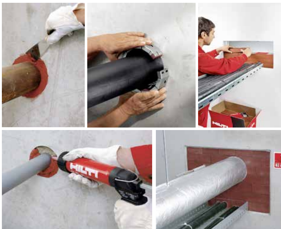
Figura 26 – Aplicação de selagens corta-fogo e fumaça
