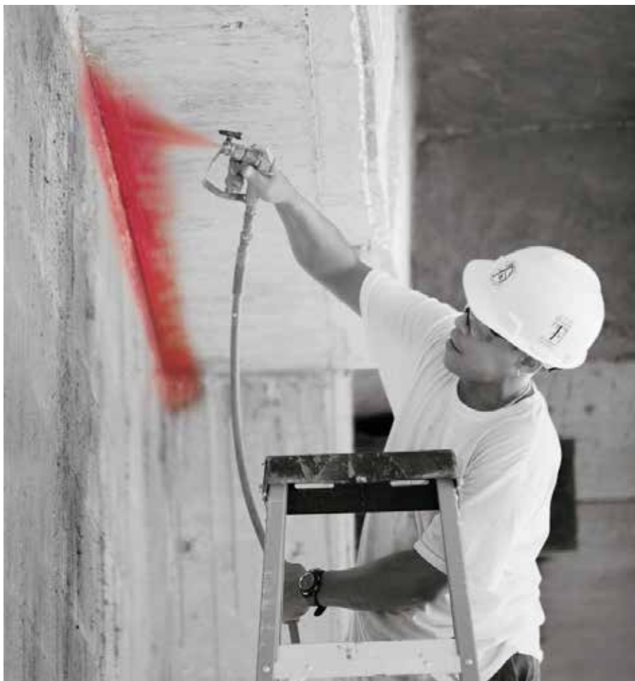
Figura 23 – Marcação de Compartimentação
