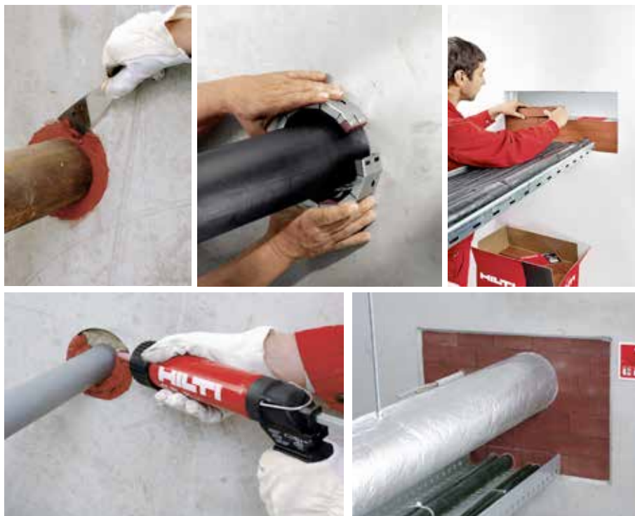
Figura 26 – Aplicação de selagens corta-fogo e fumaça
